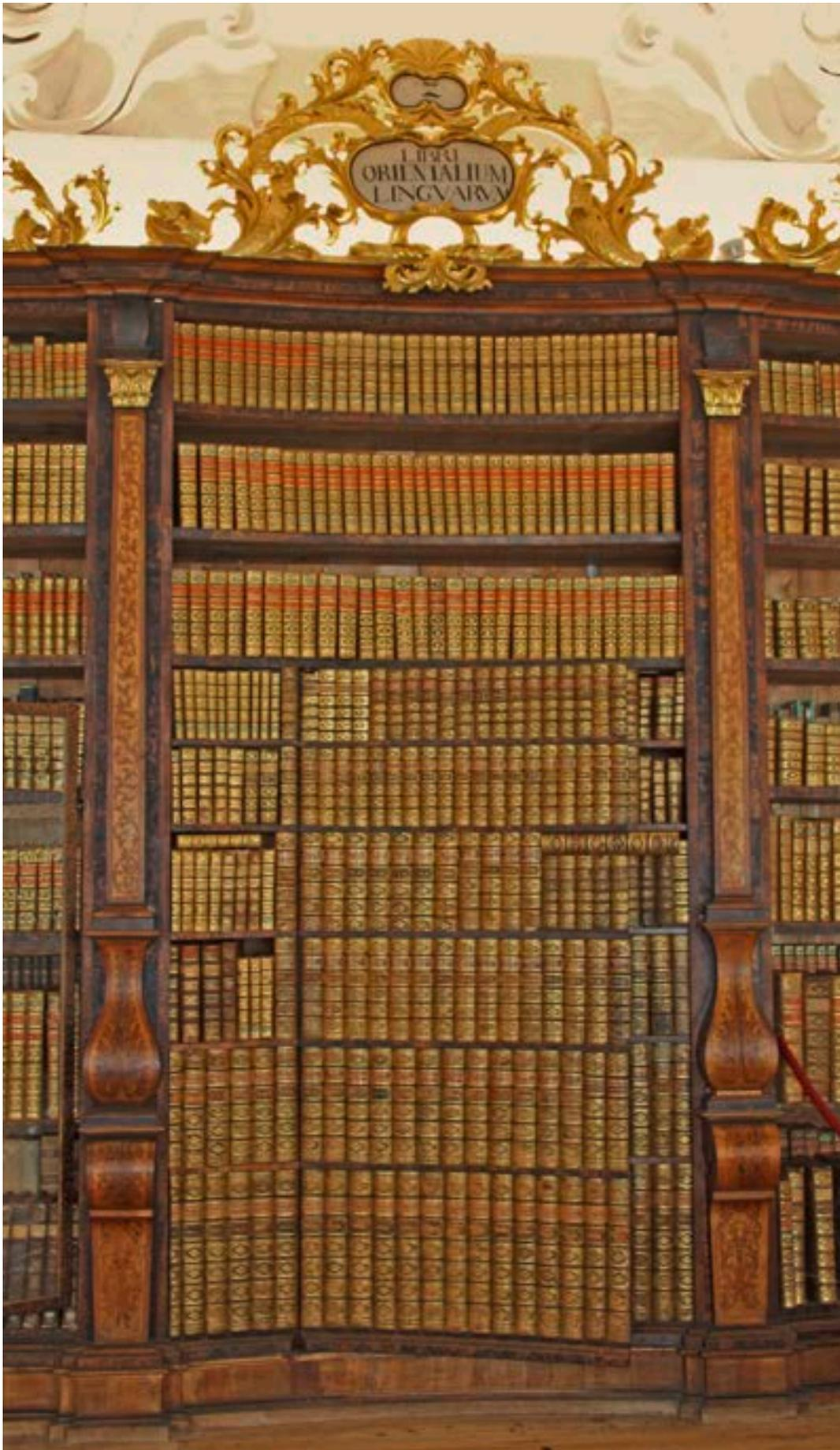
*Abb. 24* Abtei Kremsmünster, Bücherregal mit Tür zu einem Nachbarzimmer. Die Bücherrücken sind aufgeklebt, um 1707/1711.
