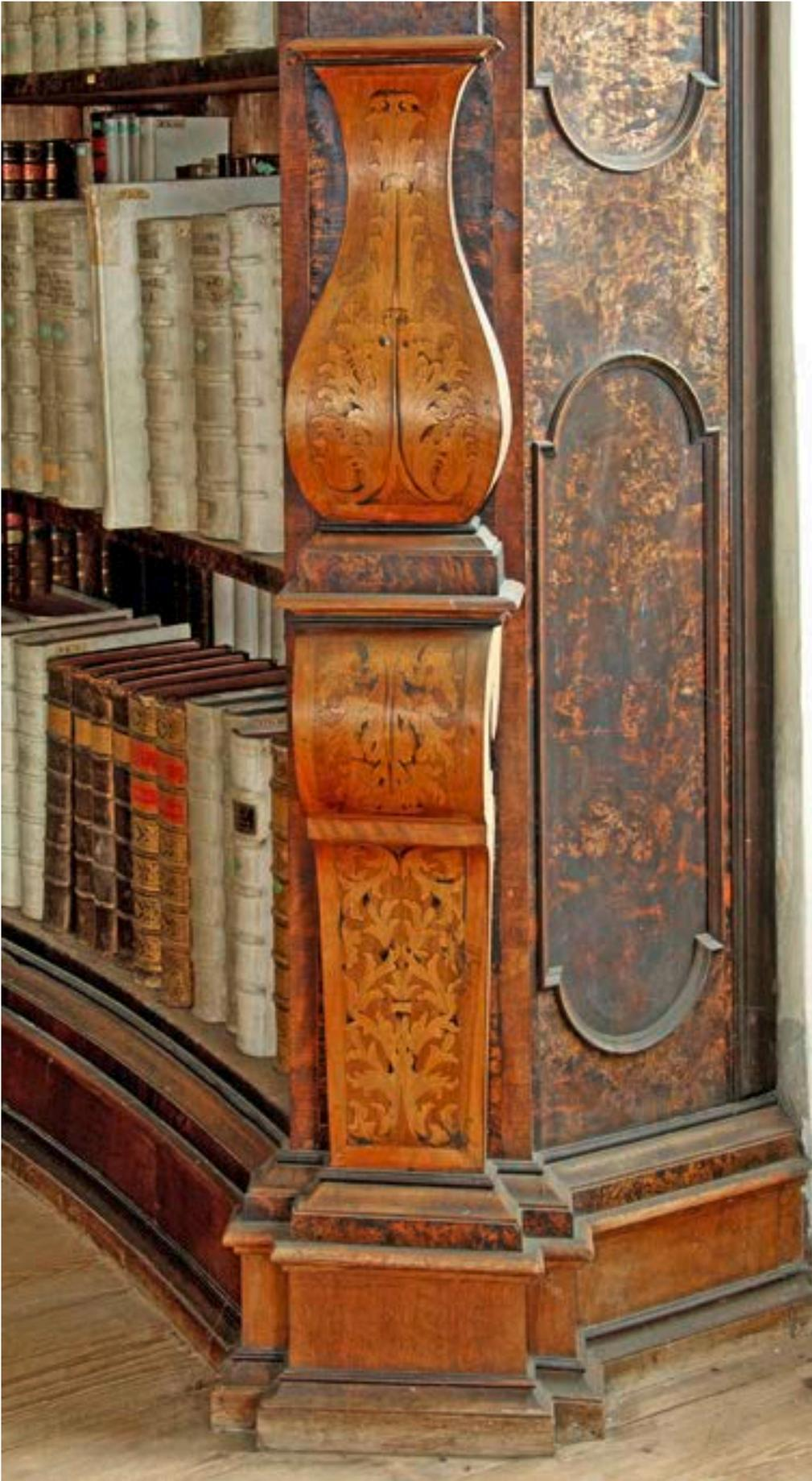
*Abb. 25* Abtei Kremsmünster, Detail eines Bücherregals mit Intarsien und eingefärbtem Pappelmaserfurnier, um 1707/1711
